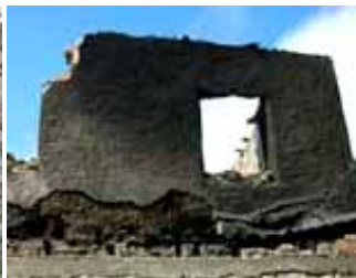
Φωτ. 5, 6: Καύση ξύλινων υπερθύρων. Εν συνεχεία κατάρρευση υπερκείμενου τόξου ή υπερκείμενης τοιχοποιίας
