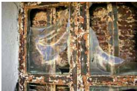
Φωτ. 1: Τήξη υαλοστασίων
