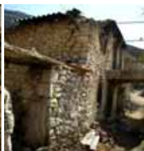
Φωτ. 11, 12: Κατακόρυφες ρωγμές στη σύνδεση εγκάρσιων τοίχων
