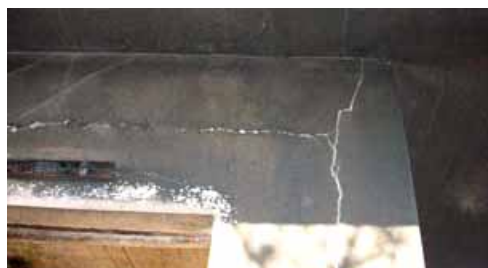
Φωτ. 18: Ρωγή σε κόμβο δοκού και υποστυλώματος (λόγω θερμικού λακτίσματος)
