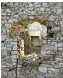
Φωτ. 5, 6: Καύση ξύλινων υπερθύρων. Εν συνεχεία κατάρρευση υπερκείμενου τόξου ή υπερκείμενης τοιχοποιίας
