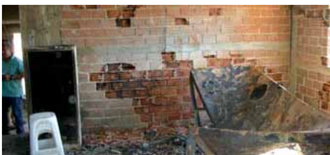
Φωτ. 19: Αποκόλληση τοίχων πληρώσεως από τα στοιχεία του φέροντος οργανισμού
