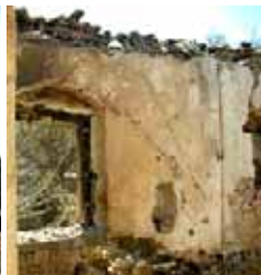
Φωτ. 5, 6: Καύση ξύλινων υπερθύρων. Εν συνεχεία κατάρρευση υπερκείμενου τόξου ή υπερκείμενης τοιχοποιίας
