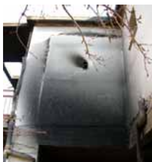
Φωτ. 19: Αποκόλληση τοίχων πληρώσεως από τα στοιχεία του φέροντος οργανισμού
