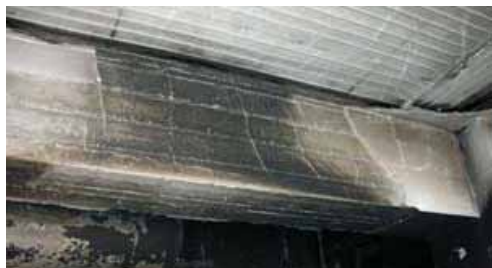
Φωτ. 17: Κατακόρυφες και λοξές (διατμητικές) ρωγμές σε δοκούς
