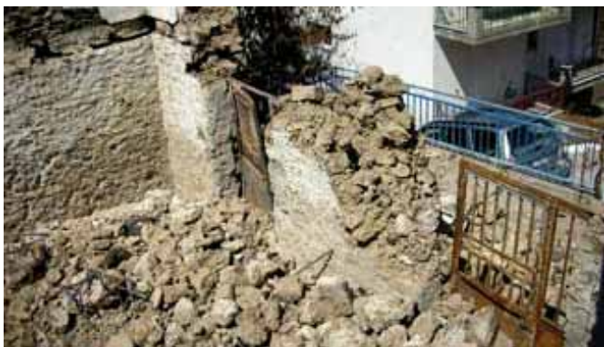
Φωτ. 13, 14: Κατάρρευση τμήματος του κτιρίου
